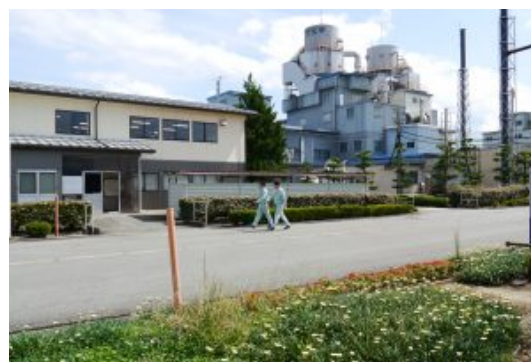
上市川沿いにある郷柿沢工場
